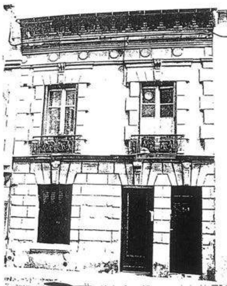
Façade en maçonnerie de pierres appareillées
