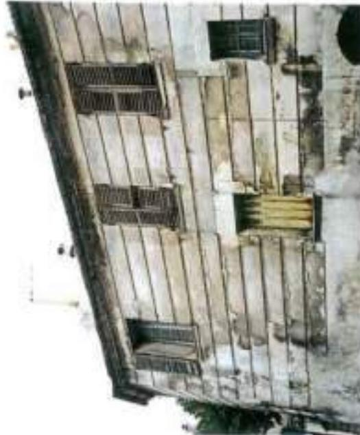
Moellons enduits au mortier de plâtre et chaux, avec faux-joints d'appareil.
